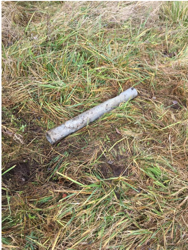
1 pav. Sunaikintas monitoringo gręžinys Nr. 47997
