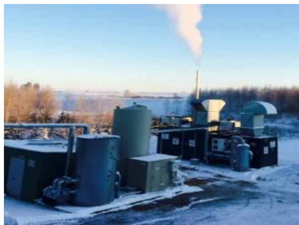
32 pav. Biologinių įrenginių energetinis blokas, gaminantis elektros energiją
