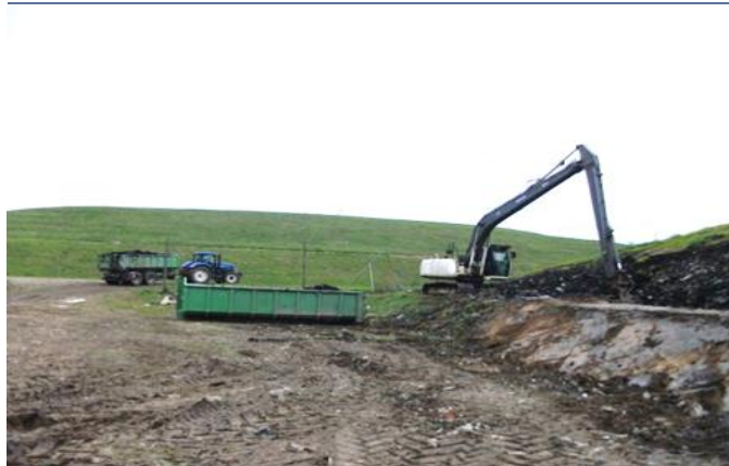
47 pav. Vyksta sąvartyno tvarkymo darbai
