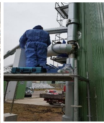
46 pav. Vis dar nesibaigia biologinio apdorojimo įrenginių statybos defektų šalinimas
