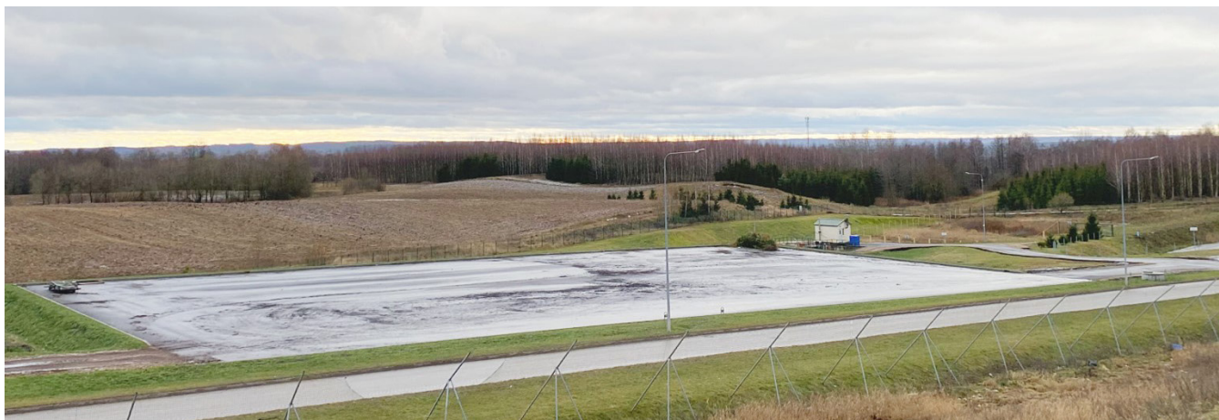
Įrengta aikštelė statybiniams atliekoms.
