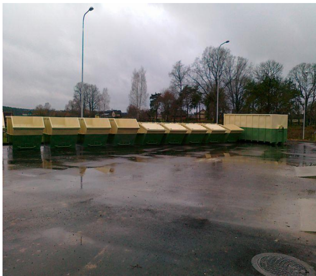
34 pav. Didelių gabaritų aikštelė Prienų raj.
